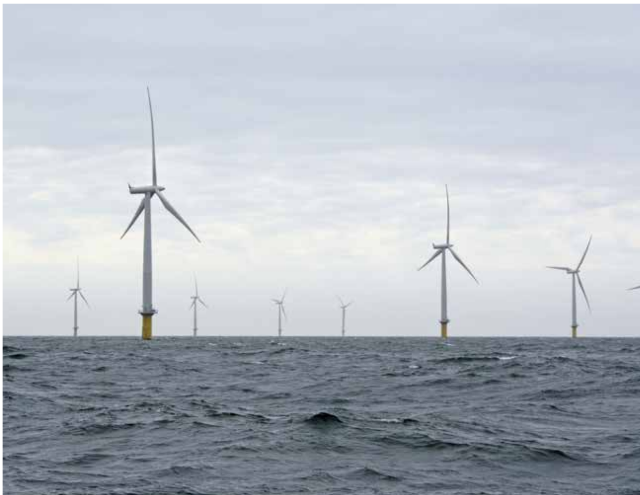
Le parc éolien de Horns Rev, au large de Esbjerg © Fabrice Nodé-Langlois
