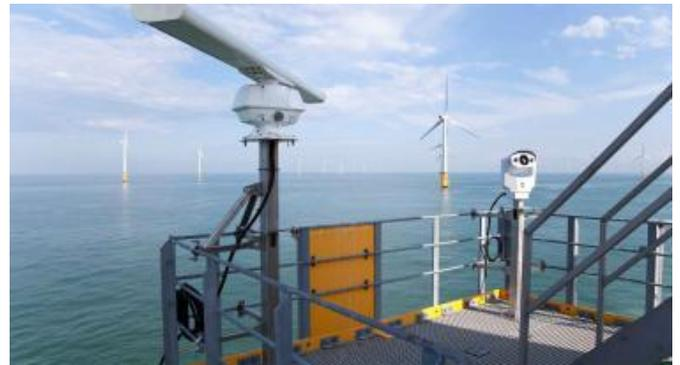
Figure 3: Système de surveillance multicapteurs (caméra thermique radar) installé au parc éolien de Thanet [2]
