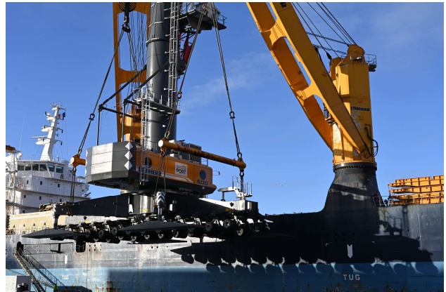
Lors de l'arrivée des grues, le 10 décembre 2020, à Saint-Nazaire, quai de la Prise d'eau.
