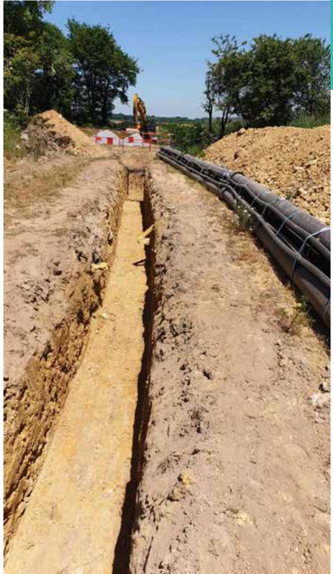
Exemple de pose d'une liaison 225 000 volts en plein champ
