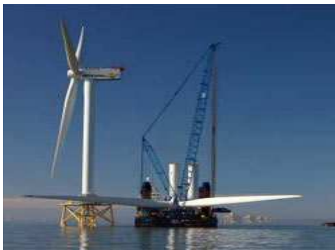
Figure 7 : Travaux de construction du parc éolien en mer d'Ormonde (Royaume-Uni – source : http://www.enerzine.com )
