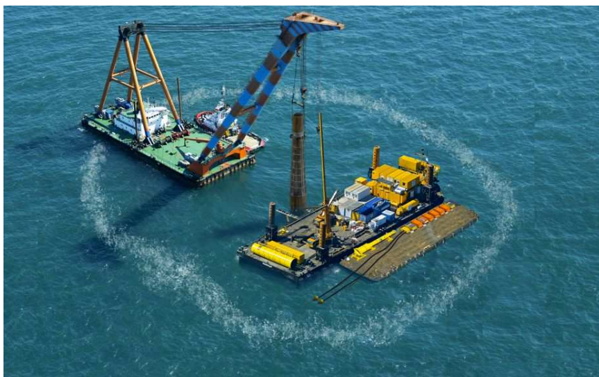
Figure 20 : . Rideau de bulles déployé autour d'une structure en Mer du Nord (source : HYDROTECHNIK LÜBECK)
